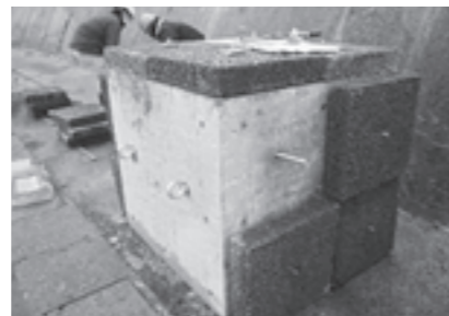
図1 海域に設置した藻場造成材（FA高含有ポーラスコンクリートパネルを固定）
