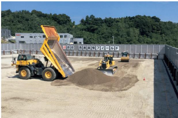
A<sup>4</sup>CSELでの自動ダンプ、自動ブルドーザ、自動振動ローラの実験
